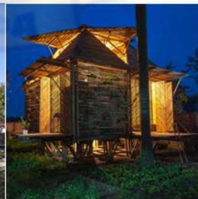
Blooming Bamboo Home (H&P Architects)
